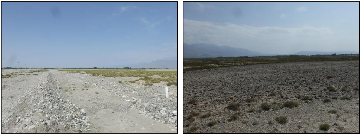
图 3.1-2 临时占地恢复情况
