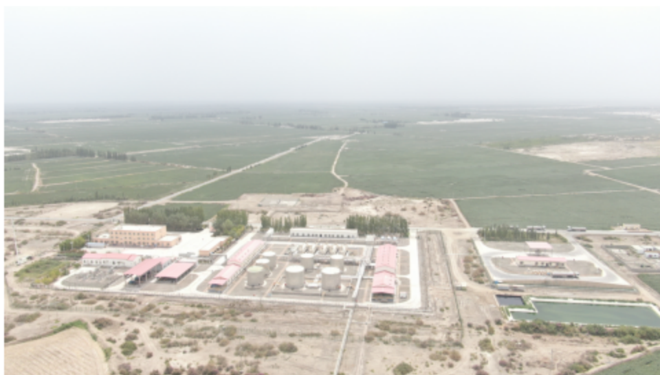
图 3.3-6 英潜联合站污水处理装置现状
