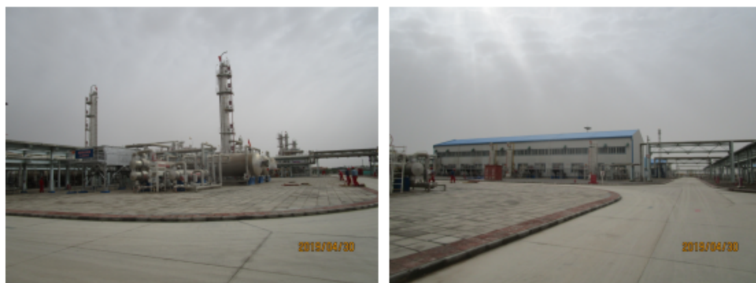
图 3.3-4 英买处理站现状
